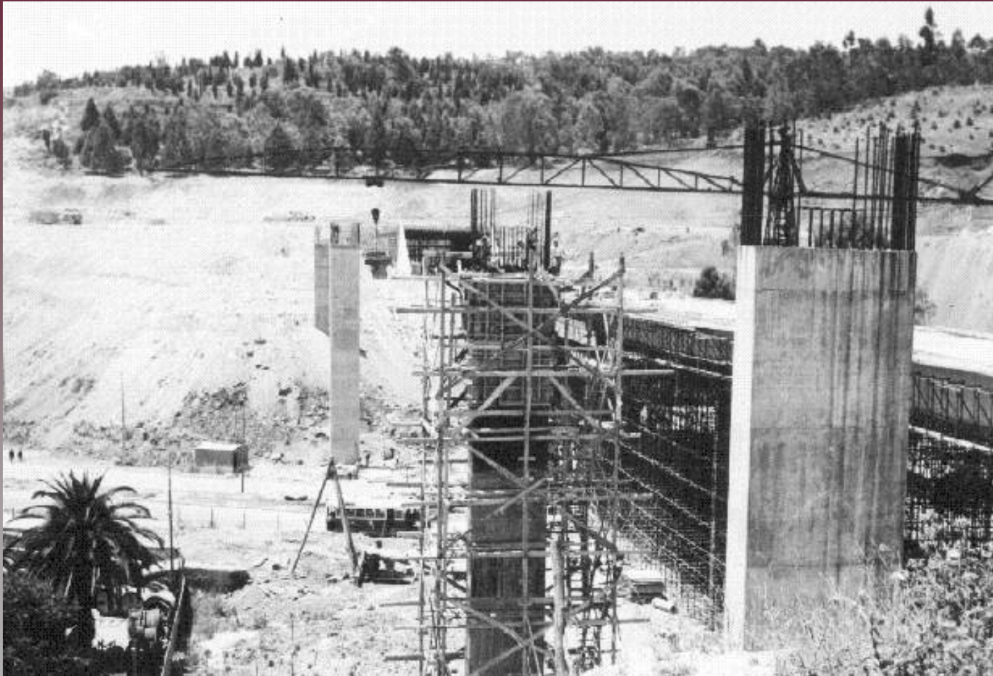
Em construção, o Viaduto que dá acesso à Ponte sobre o Tejo...
